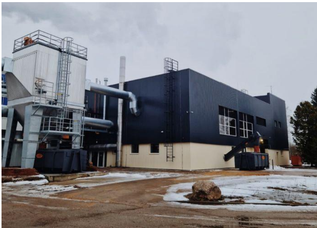
2.2.1 attēls Pārbūvētā katlumāja Pulkveža Brieža ielā 109. 2
