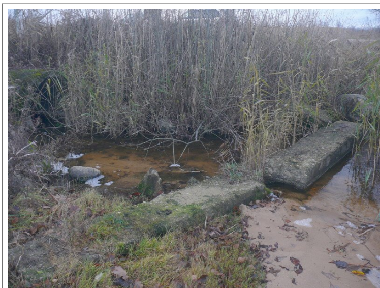
Betona sliekšnis Teiļupītes iztekā
