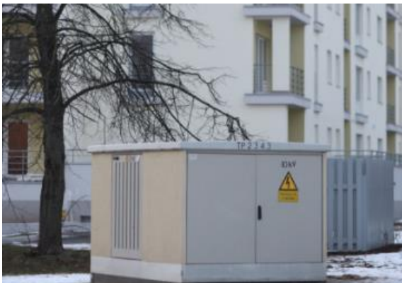
Attēls 3 Betona korpusa transformatoru apakšstacija. Tipveida komplektācija (Avots: AS “Jauda”)
