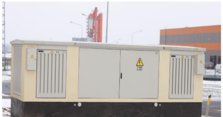
Attēls 4 Betona korpusa divtransformatoru apakšstacija. Tipveida komplektācija (Avots: AS “Jauda”)
