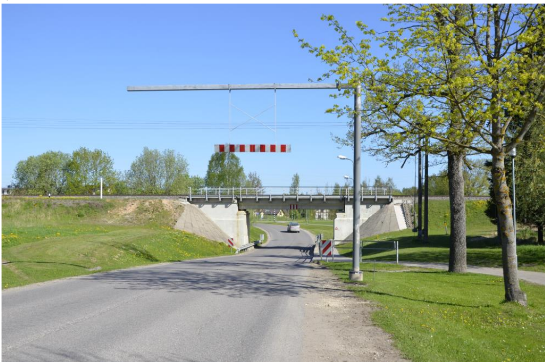
Attēls 6 „Nītaures ielas šķērsojums ar dzelzceļu”. Autors: „IE.LA inženieri”
