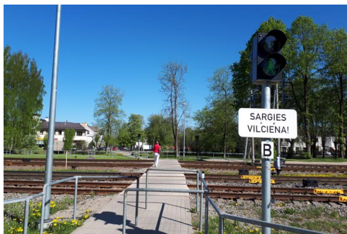
Attēls 17 „Gājēju pāreja pār dzelzceļu pilsētas centrā”. Autors: „IE.LA inženieri”
