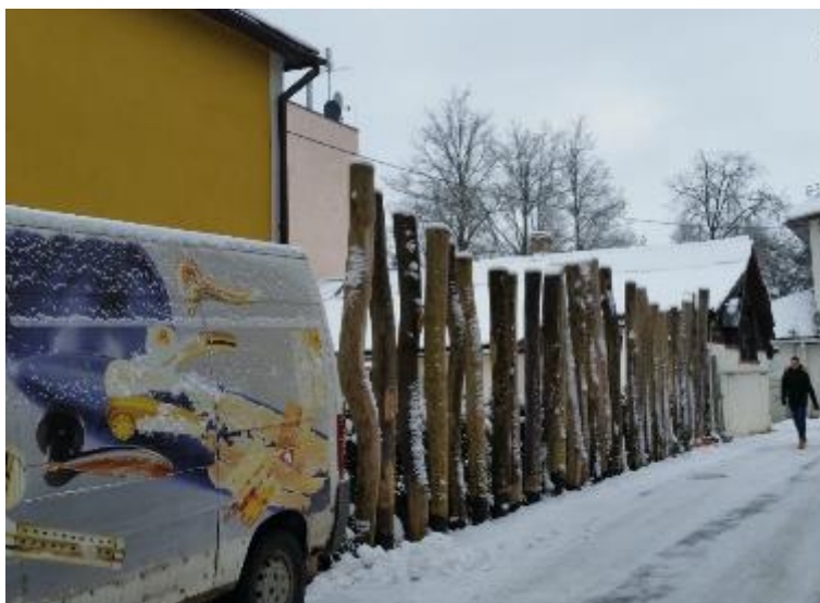
Attēls 104 Vertikālu baļķu nožogojums starp ēkām Pils ielā 2 un Pils ielā 4. 2018. gada fotofiksācija
