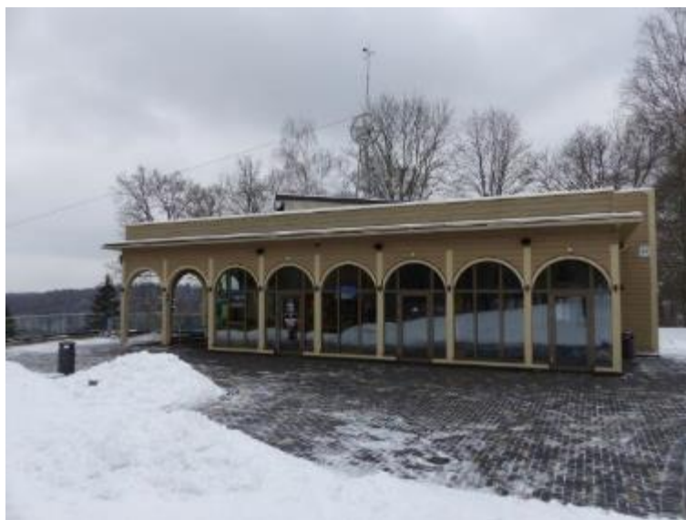
Attēls 50 Gaisa trošu ceļa pār Gauju stacijas ēka Jāņa Poruka ielā 14, Siguldā. 2018. gada fotofiksācija
