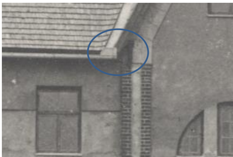
Attēls 92 Vēsturiskā lietus ūdens noteka ar savācējkārbu pie bijušā Vidzemes Šveices biedrības nama Siguldā. Vēsturiskā fotofiksācija [Turaidas muzejrezervāta arhīva materiāls]
