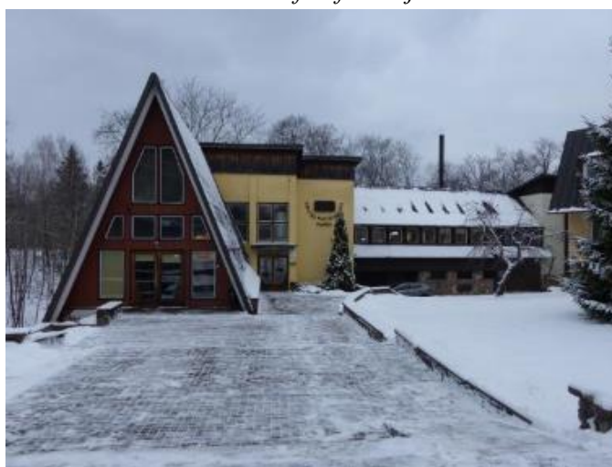
Attēls 60 Ēka Gaujas nacionālā parka administratīvo ēku kompleksā Baznīcas ielā 3, Siguldā. 2018. gada fotofiksācija
