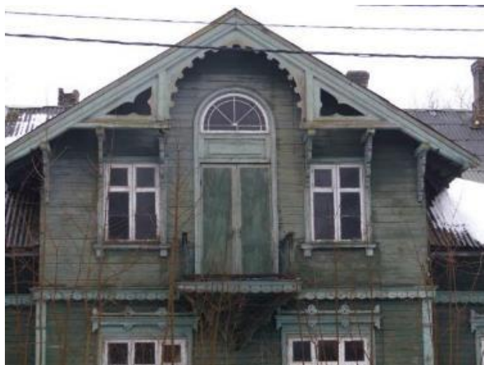
Attēls 13 Fasādes fragments ēkai Krišjāņa Valdemāra ielā 3, Villa Zaļā. 2018.gada fotofiksācija
