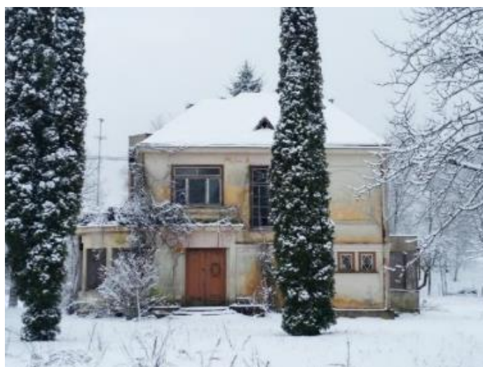
Attēls 34 Ēka Leona Paegles ielā 17. 2018.gada fotofiksācija
