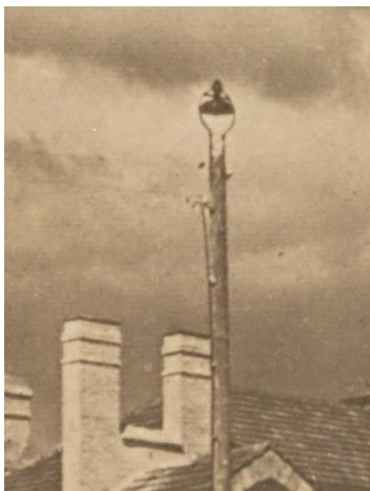
Attēls 91 20. gs. trīsdesmito gadu apgaismojuma laternas koka stabs ar zvanveida lukturi pie jaunuzbūvētās Siguldas dzelzceļa stacijas ēkas. Vēsturiskā fotofiksācija [Turaidas muzejrezervāta arhīva materiāls]
