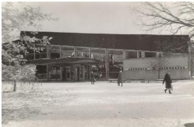
Attēls 54 Siguldas autoosta Raiņa ielā 3, Siguldā. Vēsturiskā fotofikšācija 40
