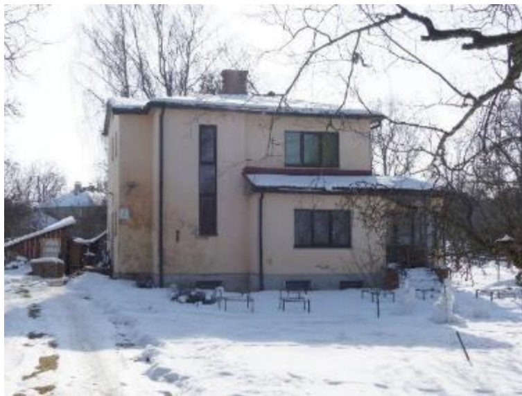
Attēls 33 Ēka Cēsu ielā 5. 2018. gada fotofiksācija
