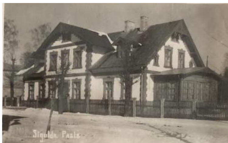
Attēls 81 Siguldas apbūve – zemesgabali no ielas norobežoti ar koka žogu ar lietiem betona stabiem. Vēsturiskā fotofiksācija [Turaidas muzejrezervāta arhīva materiāls]
