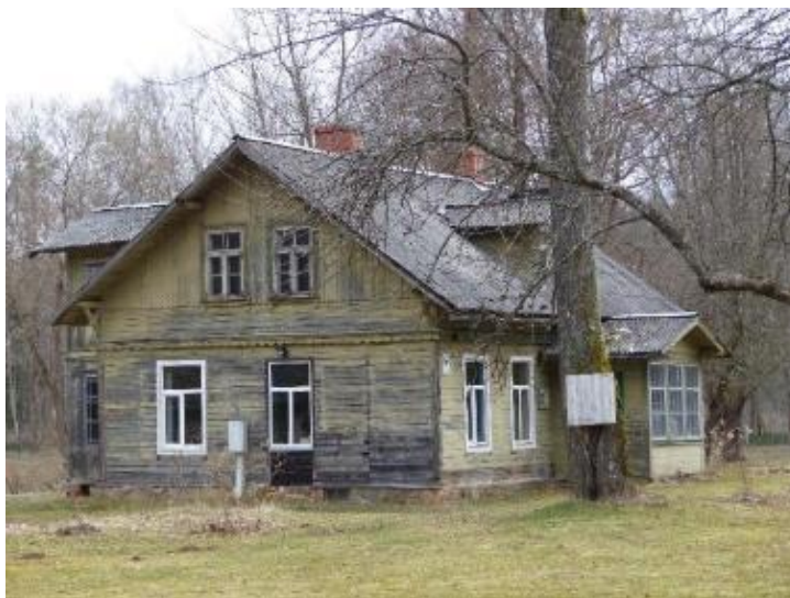
Attēls 16. Ēka Gaujas ielā 7. 2018.gada fotofiksācija
