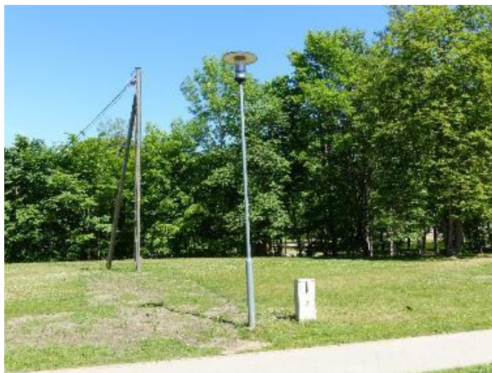
Attēls 106 Ainas iela. Komunikāciju skapis zāliena centrālajā daļā. 2018. gada fotofiksācija
