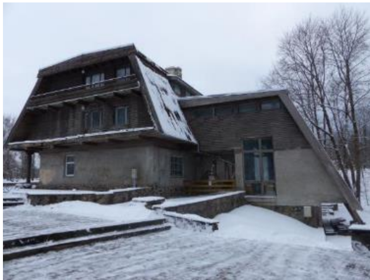
Attēls 57 Ēka Gaujas nacionālā parka administratīvo ēku kompleksā Baznīcas ielā 1, Siguldā. 2018. gada fotofiksācija
