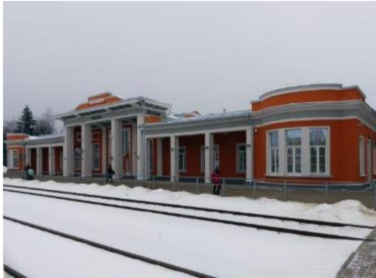
Attēls 44 Siguldas dzelzceļa stacija Ausekļa ielā 6, Siguldā. 2018. gada fotofiksācija
