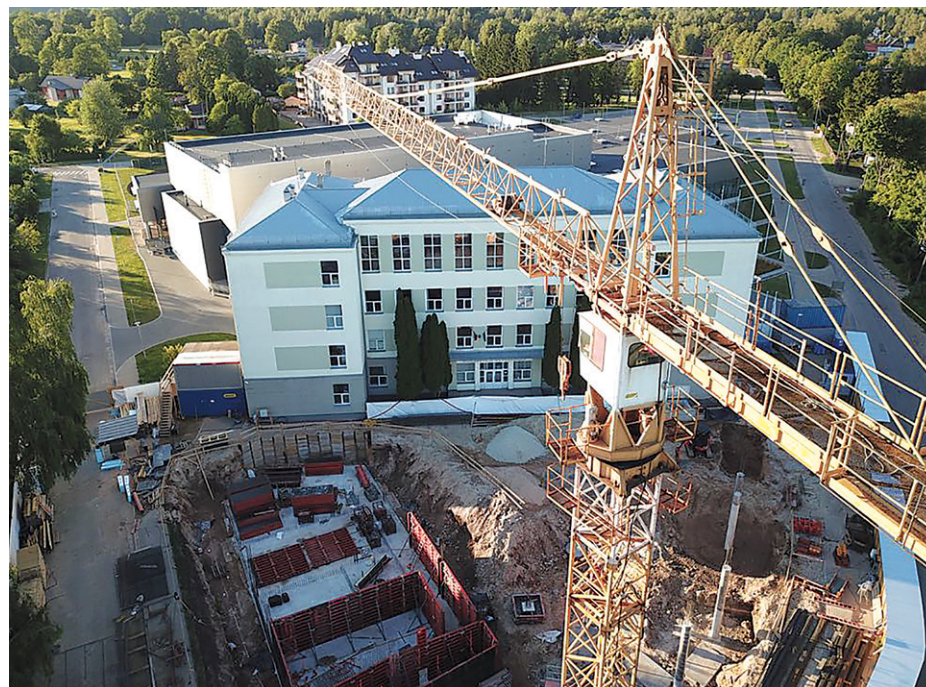
Siguldas Valsts ģimnāzijas jaunā korpusa ēkai veikta pagrabstāva pamatu izbūve.
