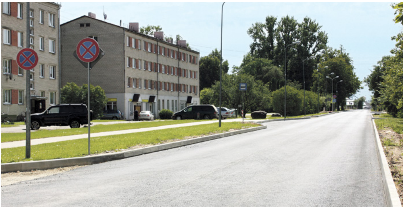
Jūlijā sākta Zinātnes ielas asfaltēšana, kur rekonstrukcijas darbi norisinās visā ielas garumā – no Vidzemes šosejas līdz autoceļam P8 „Inciems–Sigulda–Ķegums”
