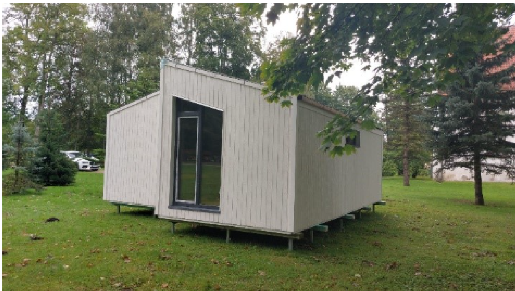
Patvaļīgi novietota ēka Baznīcas iela 2, Sigulda
