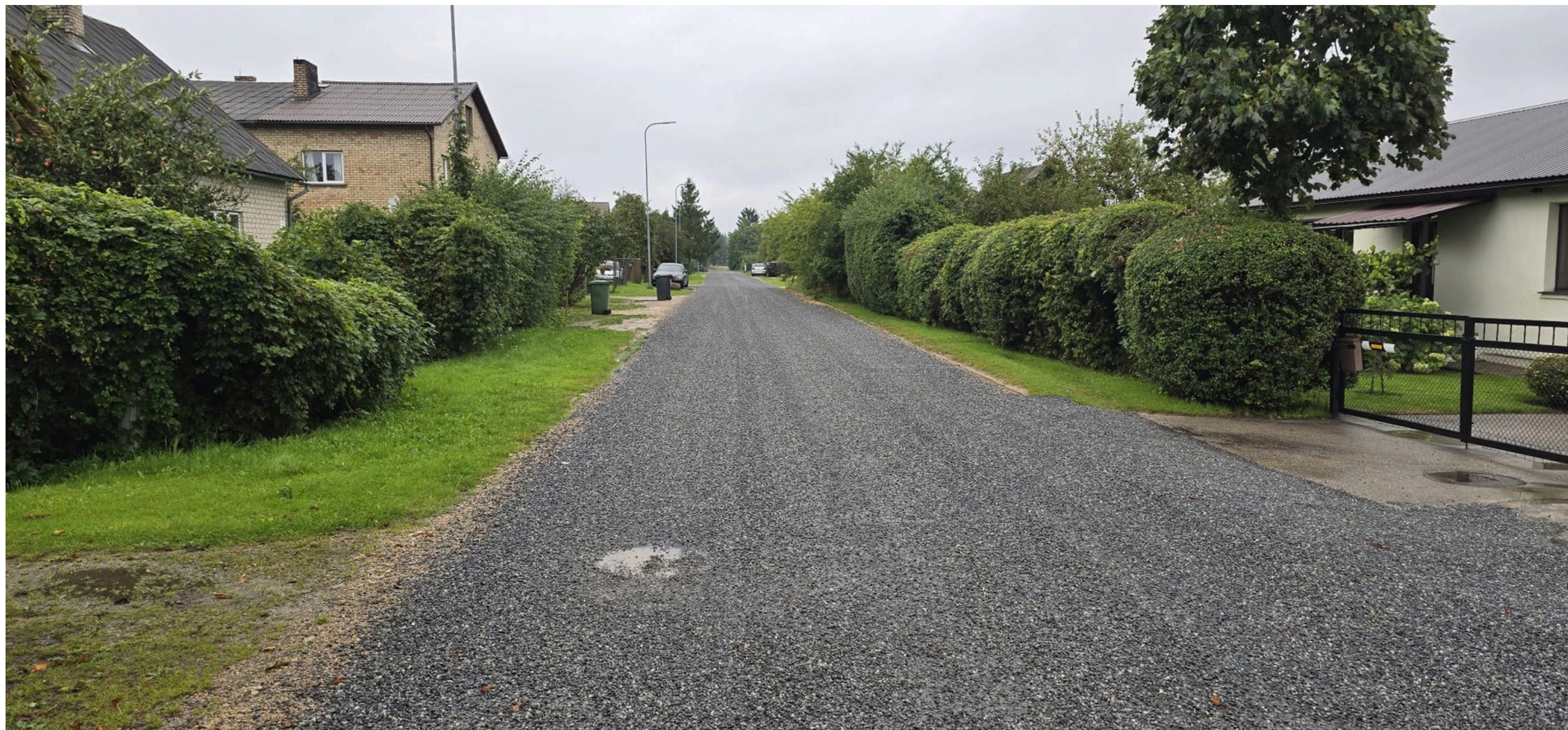
Dubultās virsmas apstrāde, Viršu iela, Sigulda
