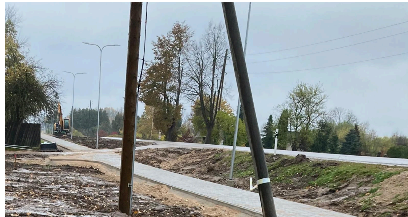
Allažu gājēju ietves izbūve. Notiek ietves izbūves darbi.
